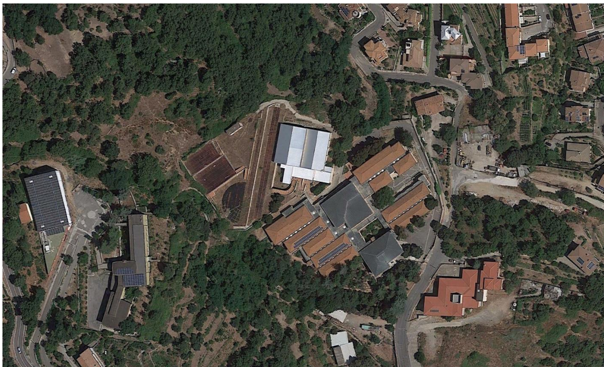
Figura 1 Foto aerea del complesso scolastico
