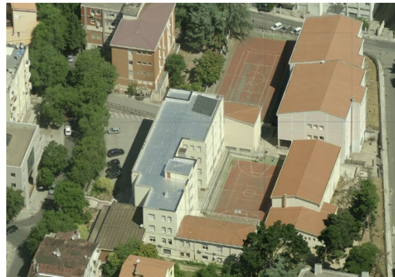
Figura 6 Foto aerea - fonte Sardegna Foto Aeree Vista Sud (da Via Fancello)
