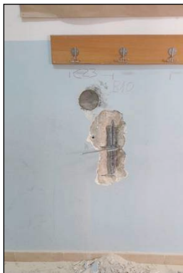
Fig. 81-82 Prelievo campione armatura metallica B 10
