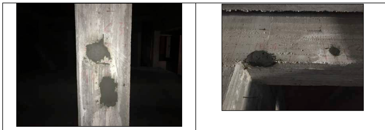
Figg. 77-78 Ripristino zone prelievo campioni armatura metallica
