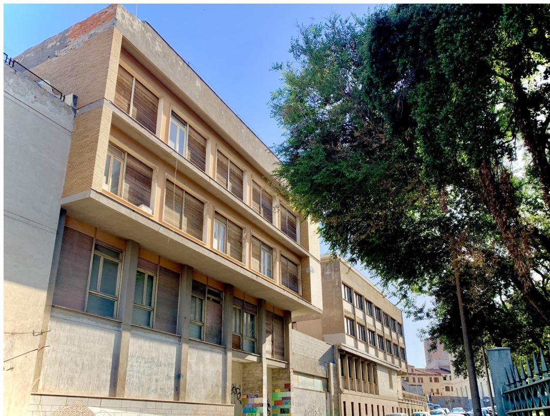
Figura 12_Vista sui prospetti degli edifici originariamente destinati a Questura (in primo piano) e al Provveditorato agli Studi di Sassari e all'Archivio di Stato (in secondo piano), via G.M.Angioy
