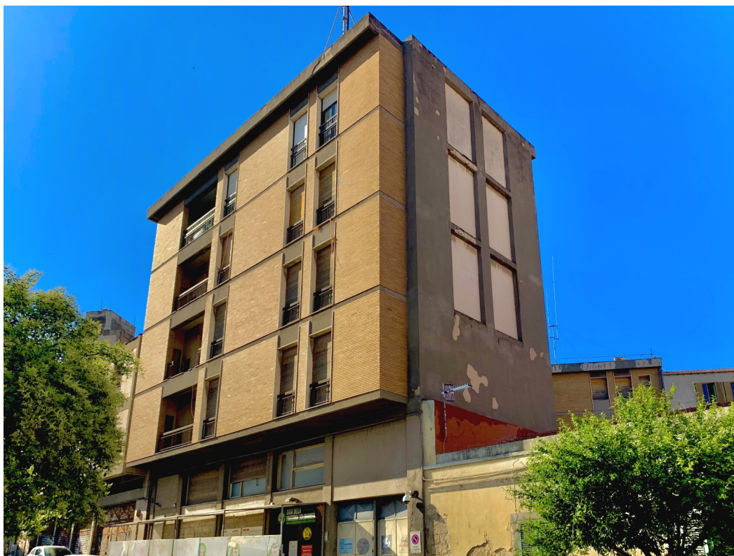
Figura 13_Vista sul prospetto dell'edificio originariamente destinato a Questura, Corso Margherita di Savoia
