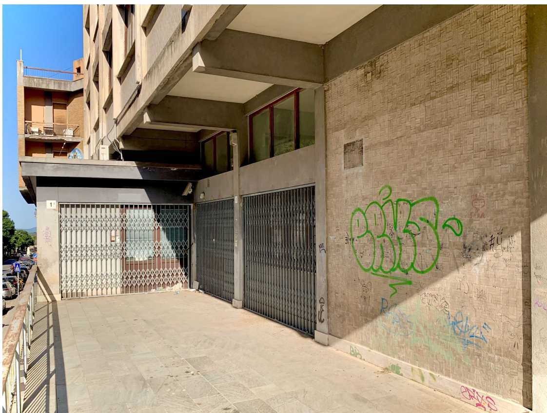
Figura 18_Vista sull'ingresso alla sala lettura dell'Archivio di Stato (sulla sinistra, al civico n. 1a) e sulla hall di ingresso del Provveditorato agli Studi di Sassari (sulla destra, al civico 1) – terrazza sulla via G.M.Angioy
