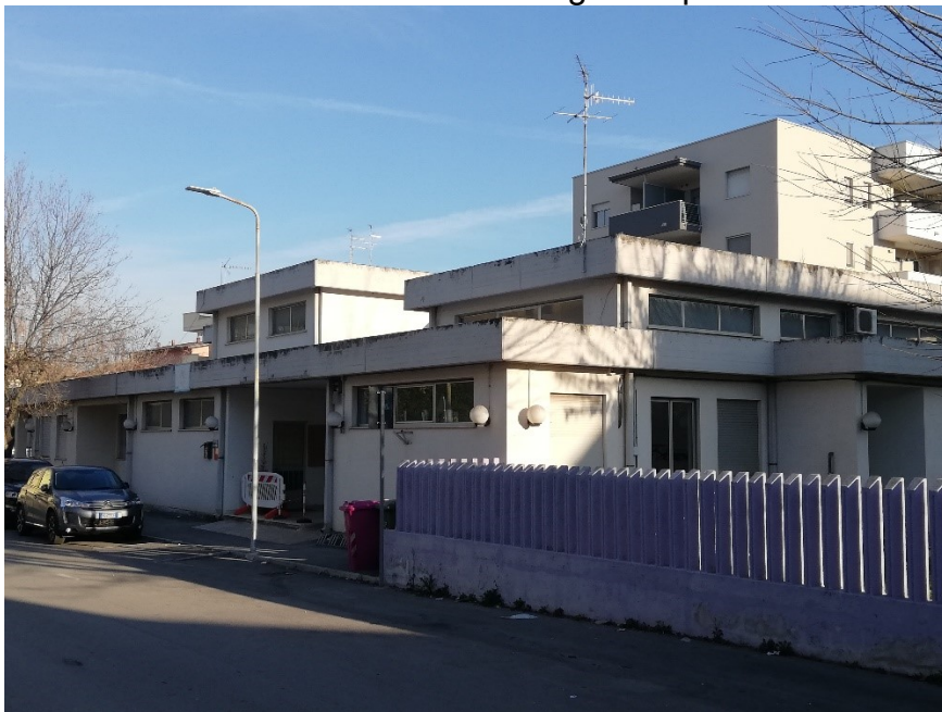
Foto 2 – vista lato Ovest – attuale ingresso pedonale
