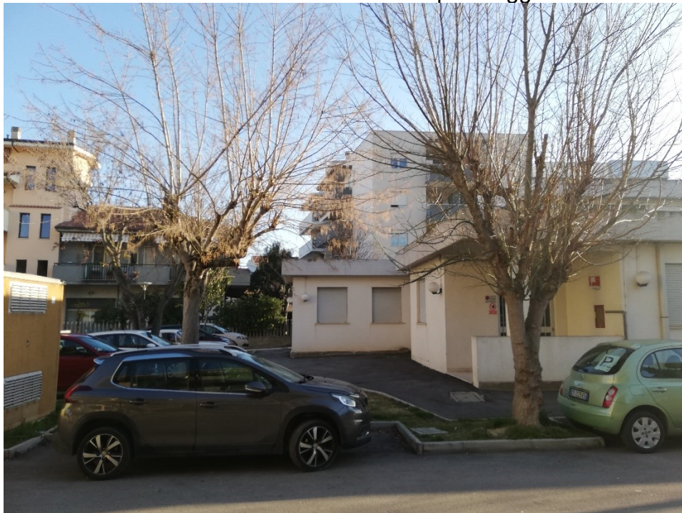
Foto 3 - vista lato Nord/Ovest – attuale parcheggio
