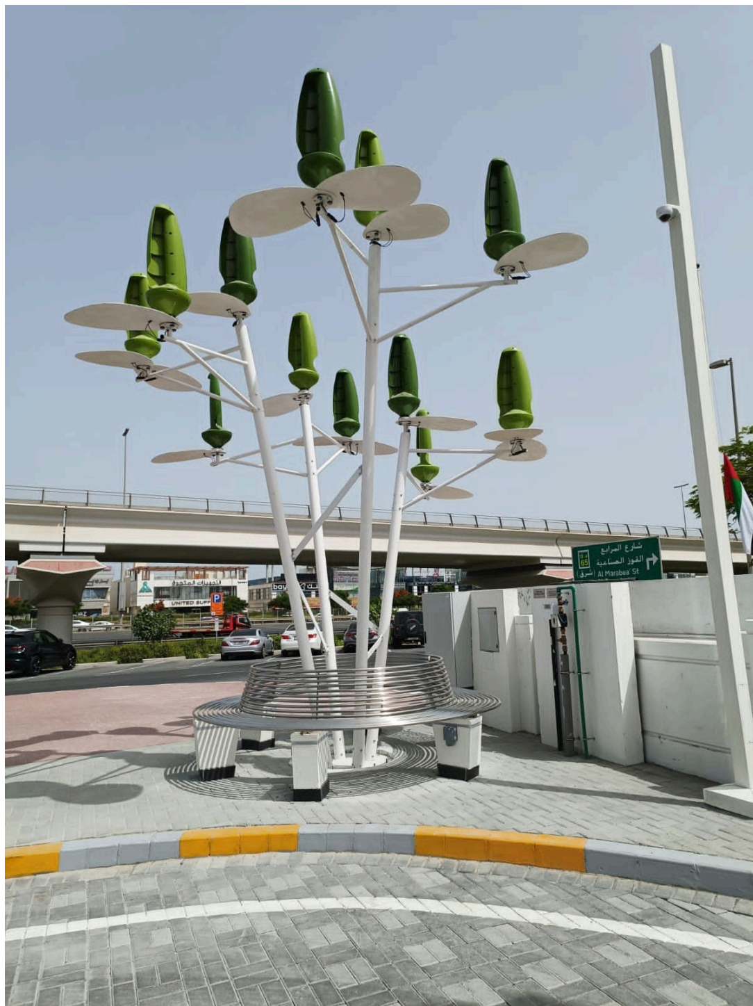
Esempio di sistema ibrido microeolico e fotovoltaico
