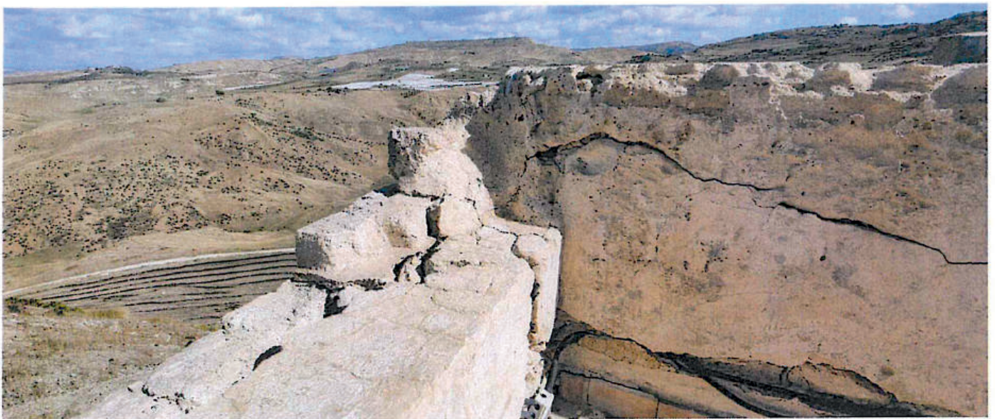
Cantonale N-O si evidenziano le zone con avanzato stato di degrado
