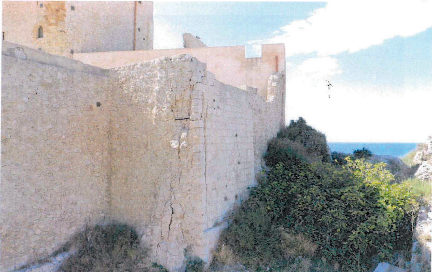
Parete N-O interessata da avanzato stato di degrado
