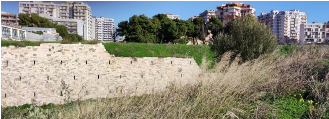
FIGURA 11 | MURO DI TERRAZZAMENTO CHE DELIMITA IL SALTO DI QUOTA VERSO IL MARE
