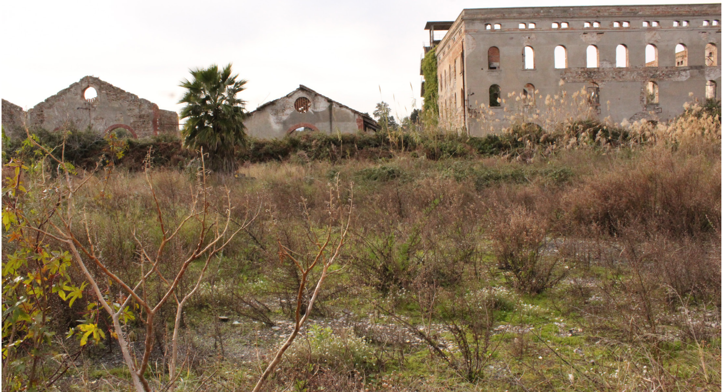
Foto dell'area con vista l'ex Montecatini
