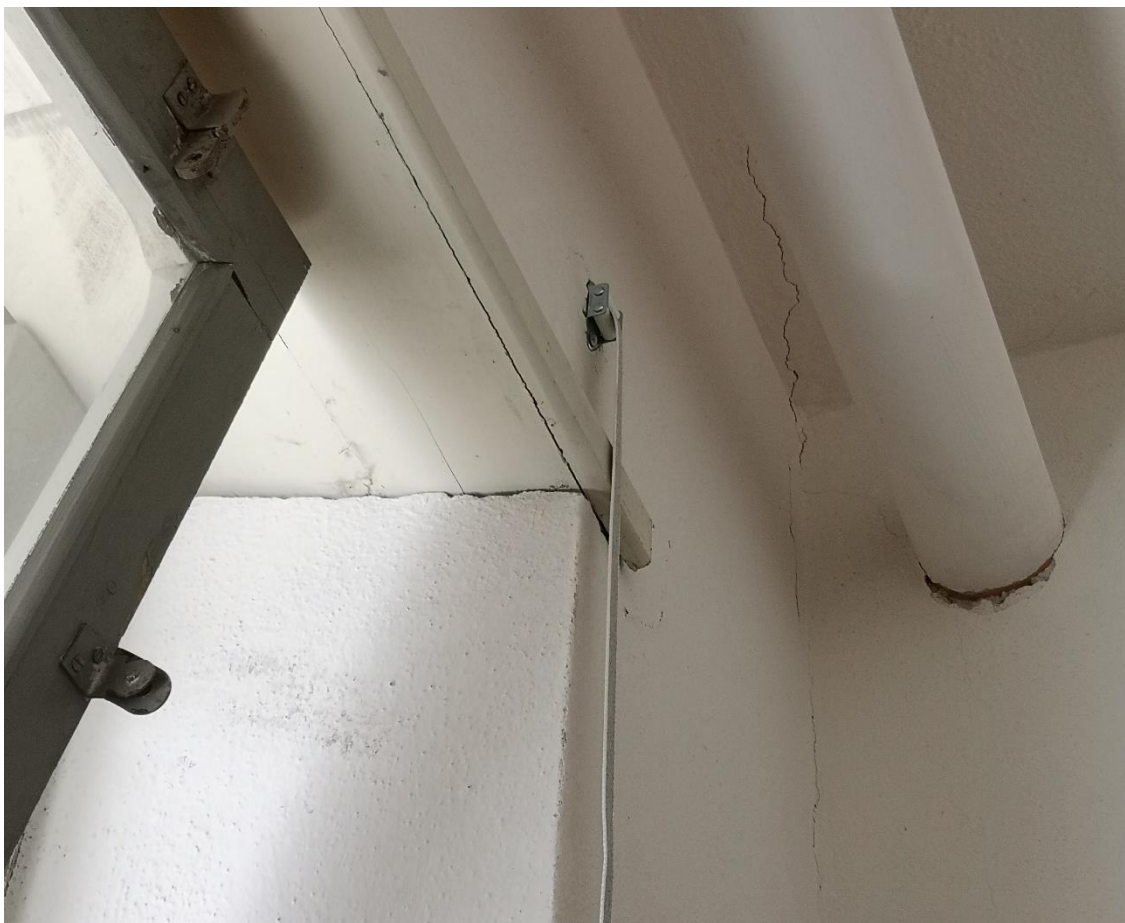
Figura 24: Fessurazioni muratura edificio ex A.I.A.S.
