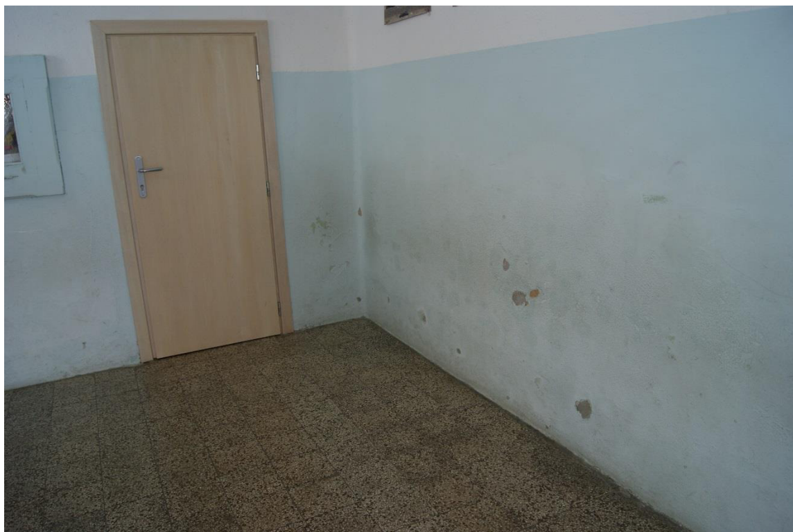
Figura 73: Intonaco danneggiato ed umidità al piano terra
