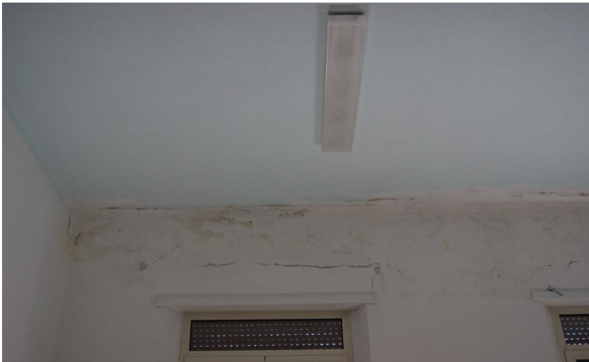
Figura 60: Dettaglio infiltrazioni, crepe e macchie d'umidità in aula docenti
