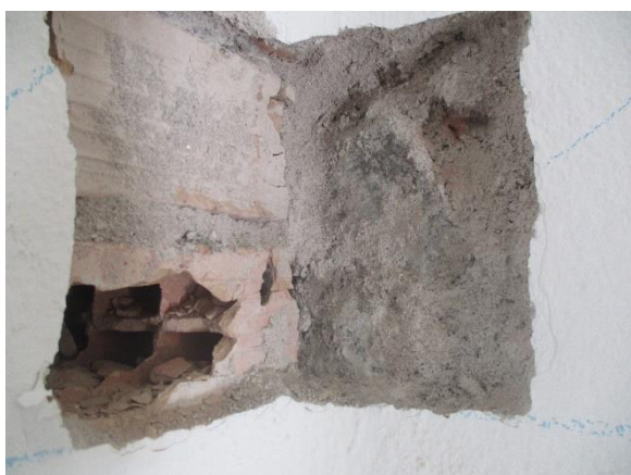
Foto 11 - Particolare della tipologia di muratura in foratoni orizzontali.
