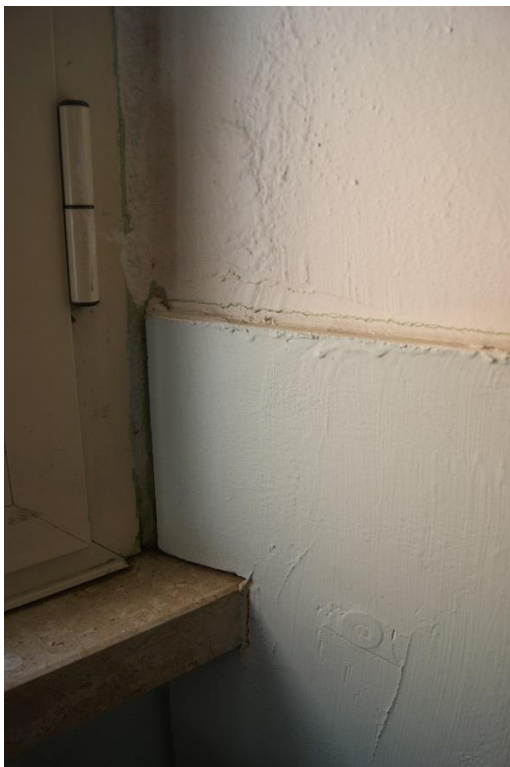
Figura 67: Rivestimenti murari ammalorati
