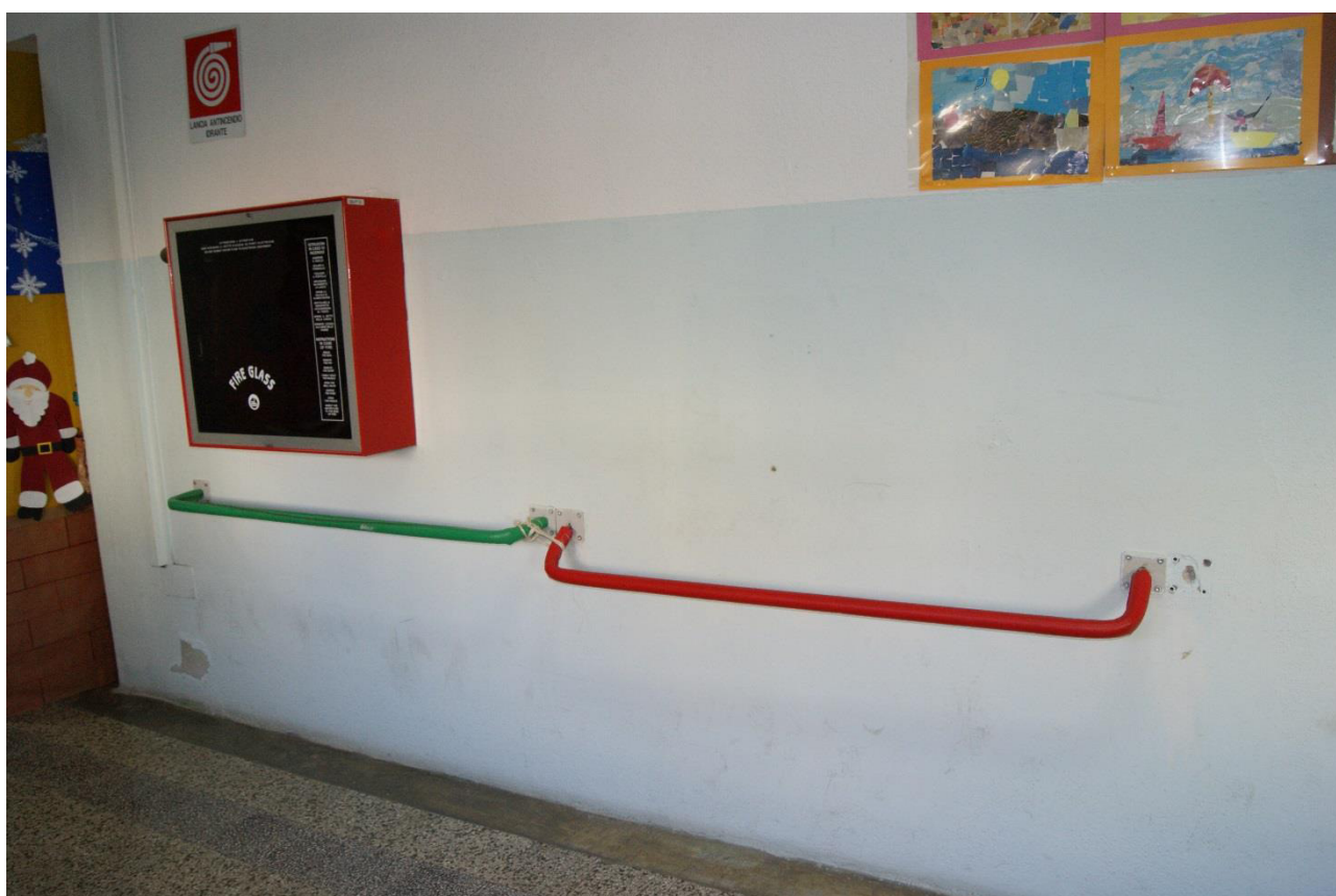
Figura 50: Maniglioni per diversamente abili danneggiati
