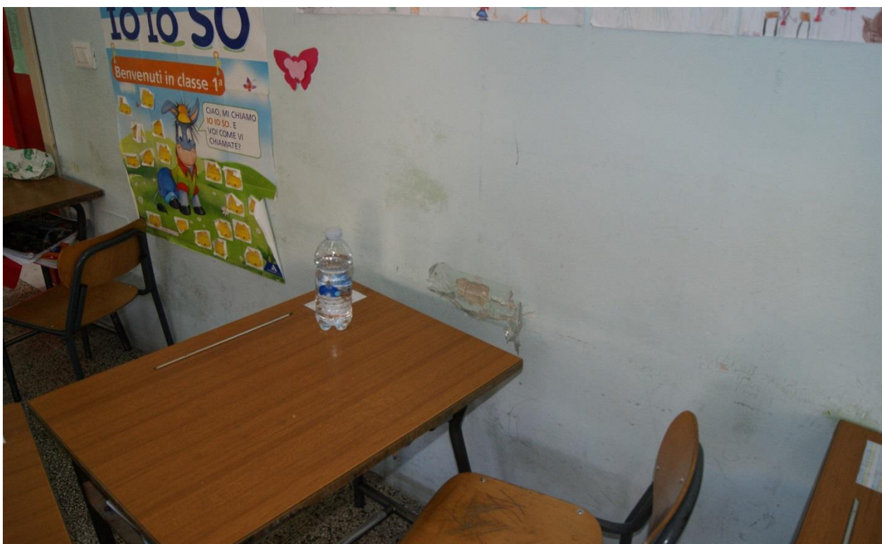
Figura 68: Intonaco danneggiato e distaccato all'interno delle aule
