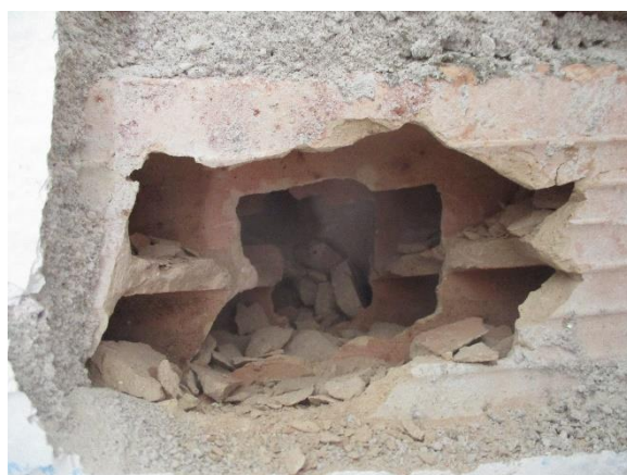
Foto 12 - Particolare della tipologia di muratura in foratoni orizzontali.
