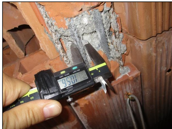
Foto 7 - Rilievo del solaio condotto mediante demolizione localizzata dell'intradosso.
