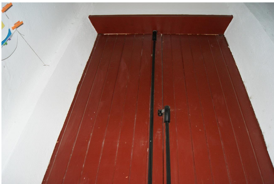
Figura 51: Portone d'accesso - sono visibili fessure da cui provengono numerosi spifferi
