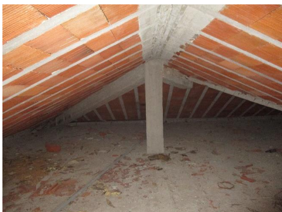
Foto 9 - Vista di insieme della presenza di pilastro in falso nel sottotetto.
