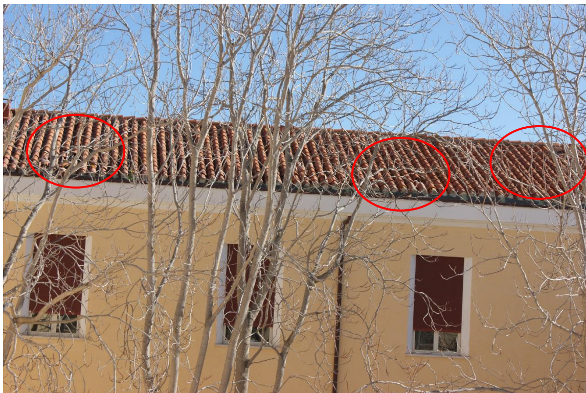
Figura 15: Dettaglio copertura da ripristinare
