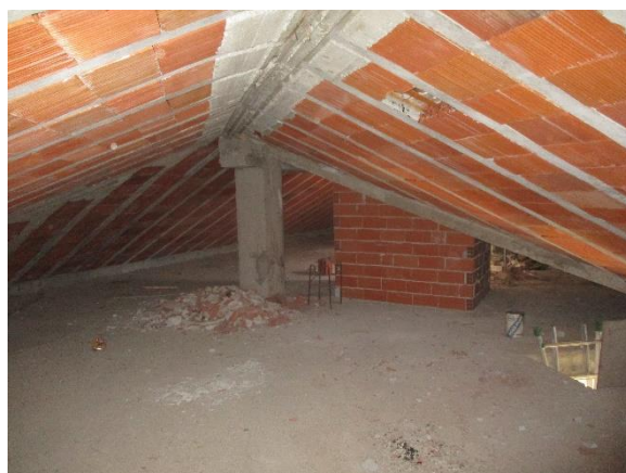
Foto 10 - Vista di insieme della presenza di pilastro in falso nel sottotetto.
