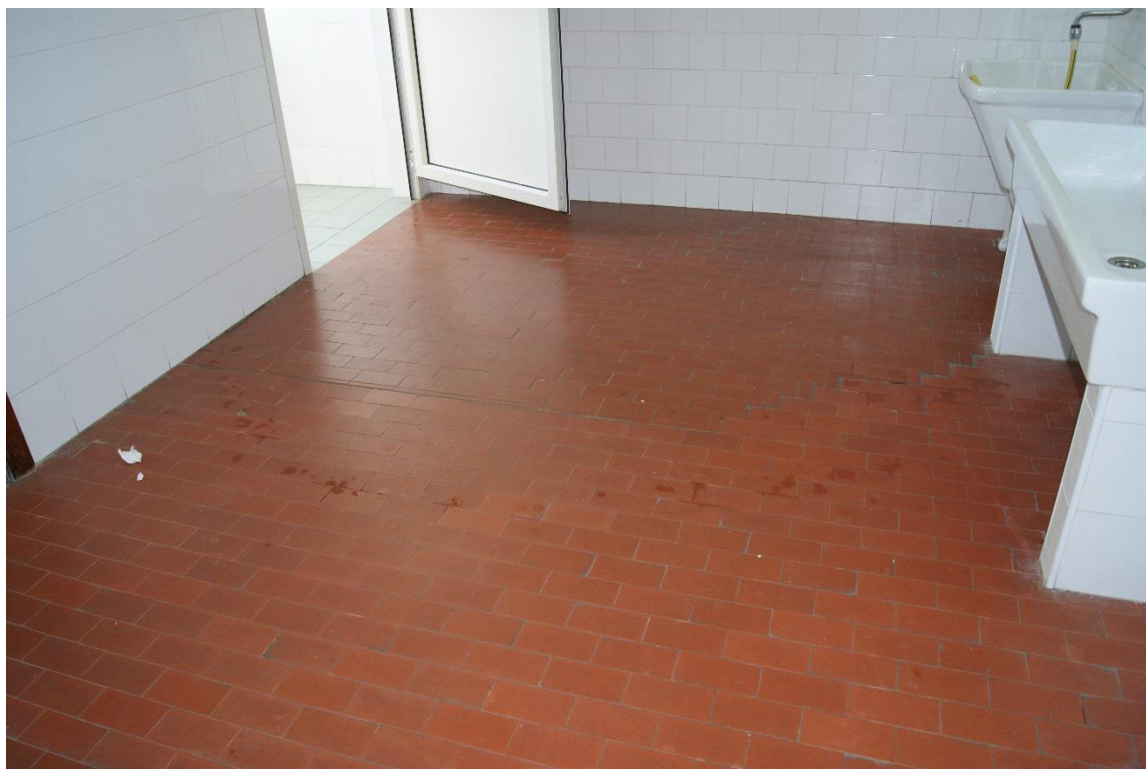
Figura 49: Pavimentazioni danneggiate nei bagni non ristrutturati
