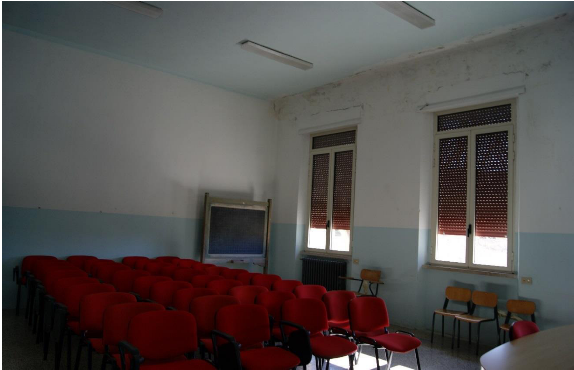
Figura 59: Infiltrazioni, crepe e macchie d'umidità in aula docenti
