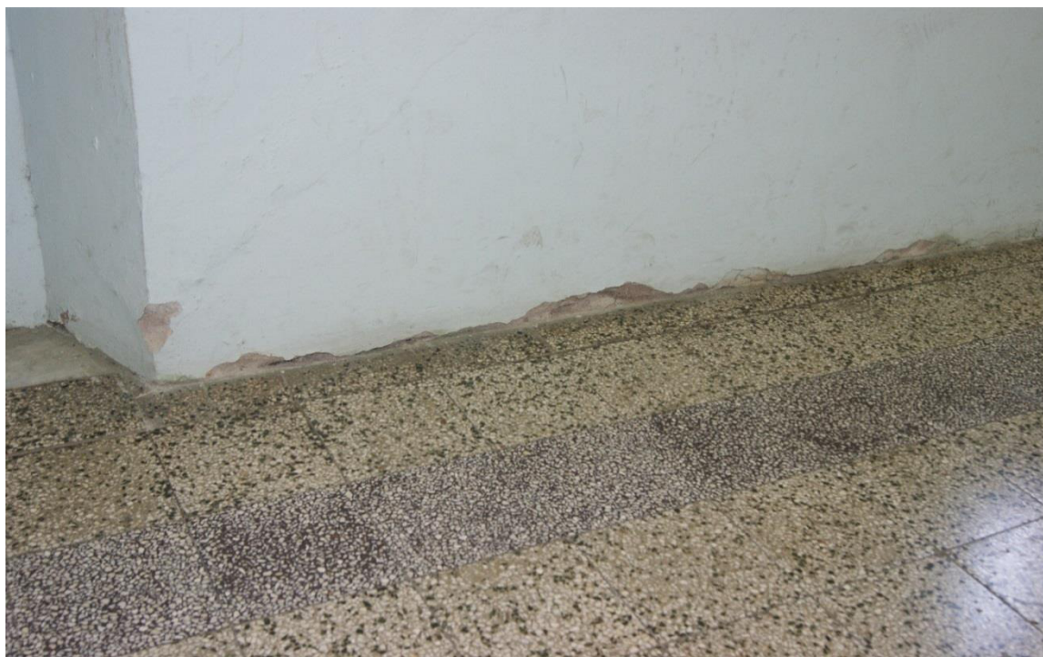
Figura 65: Distacco di intonaco nell'attacco muratura - pavimento
