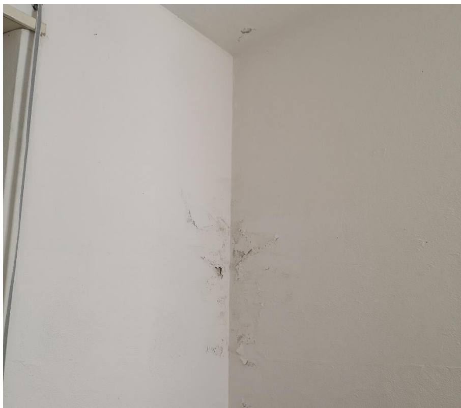
Figura 25: Dettaglio Infiltrazioni di umidità nella muratura edificio ex A.I.A.S.
