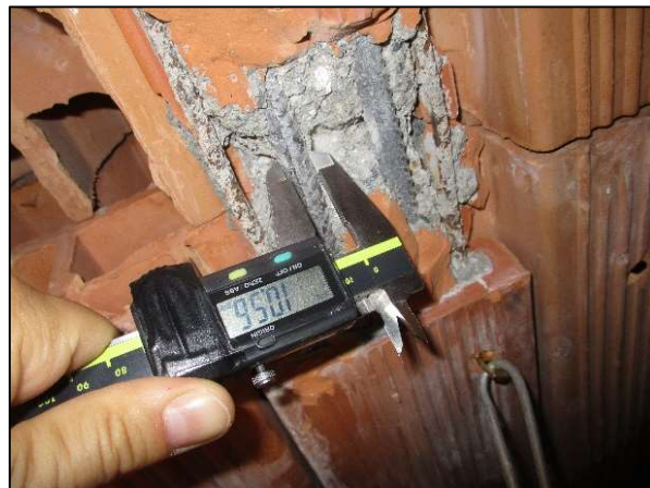
Foto 2 - Rilievo del solaio condotto mediante demolizione localizzata dell'intradosso.
