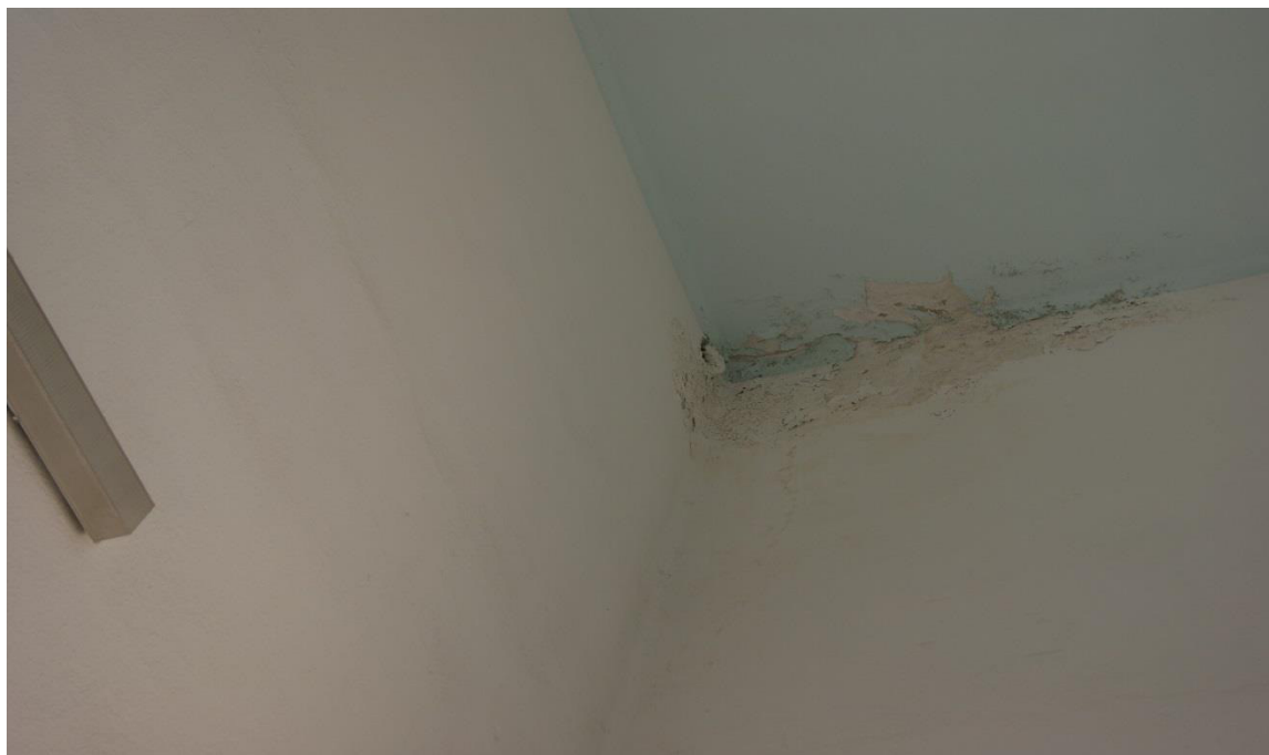
Figura 61: Macchie d'umidità, muffe e distacchi d'intonaco al piano primo
